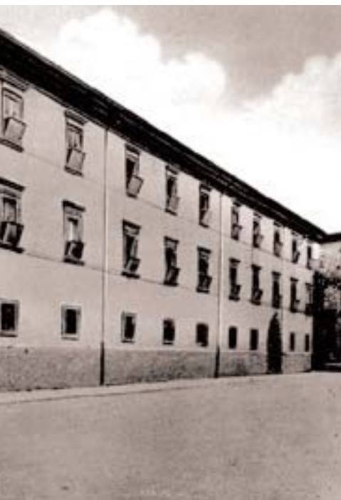
A fianco: Prospetto del convento in una foto dei primi anni Trenta del ‘900.
